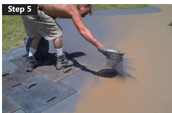
Step 5 Sprinkling colour hardener
